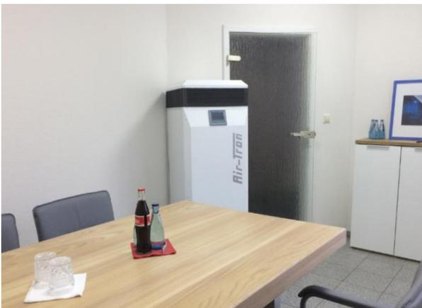
Das Hochleistungs-Luftreinigungssystem ermöglicht mit bis zu **1400 m<sup>3</sup>** Luftmenge pro Stunde eine hohe Luftwechselrate von oftmals gewünschten 6 oder mehr Luftwechsel pro Stunde.
